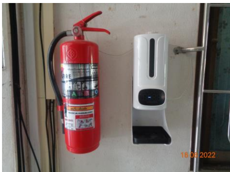
ถังดับเพลิงแบบเคลื่อนที่
